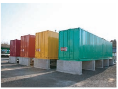
メタンガスのプラント (古河市)
